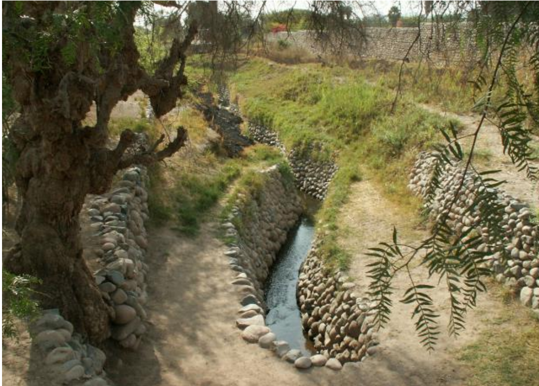
Abb. 27. Cantalloc, Peru. Auslauf des Wasserstollens in den Bewässerungskanal (Foto Davide Mauro, https://en.wikipedia.org/wiki/Puquios ).
