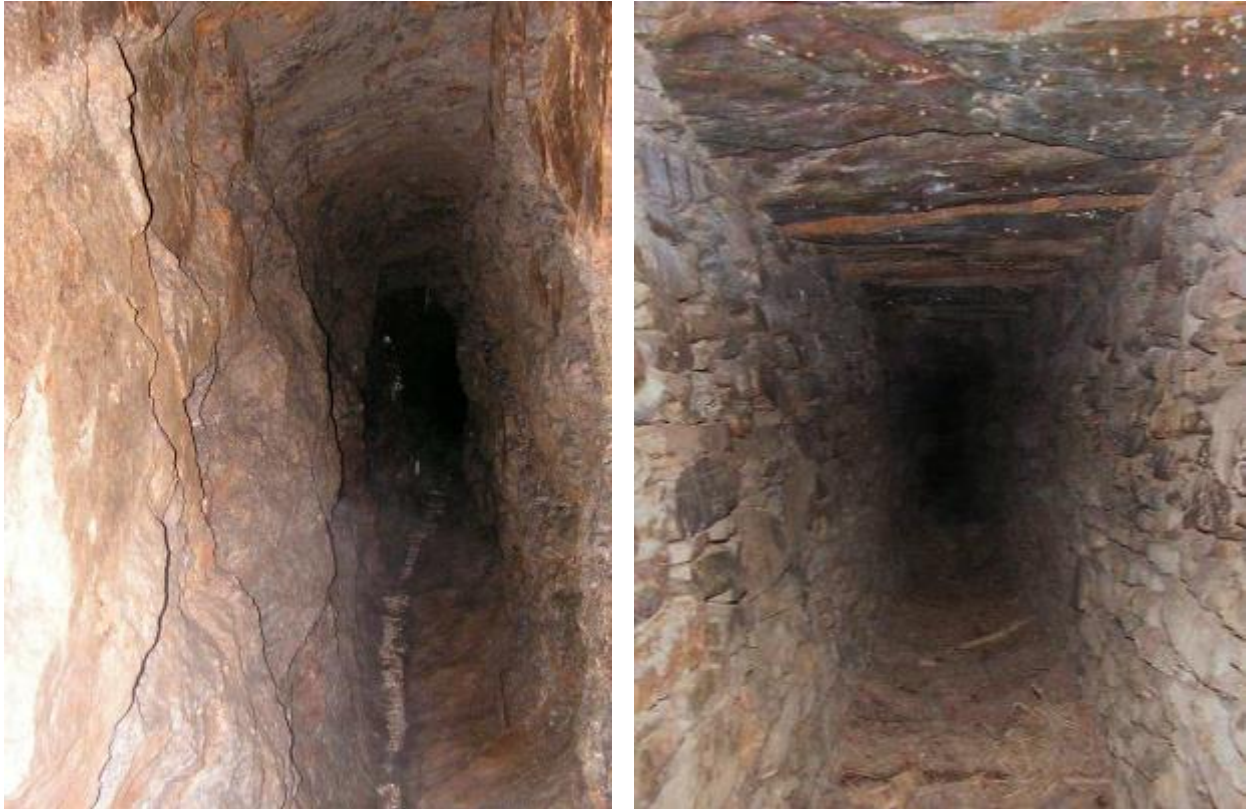
Abb. 41. Links: Profil des östlichen Stollens Aš-Skřivánčí vrch (2012). Rechts: Anfangsabschnitt des Stollens Podhradí mit Steinauskleidung (2009). Fotos: B. Karban, vollständige Dokumentation im Anhang.
