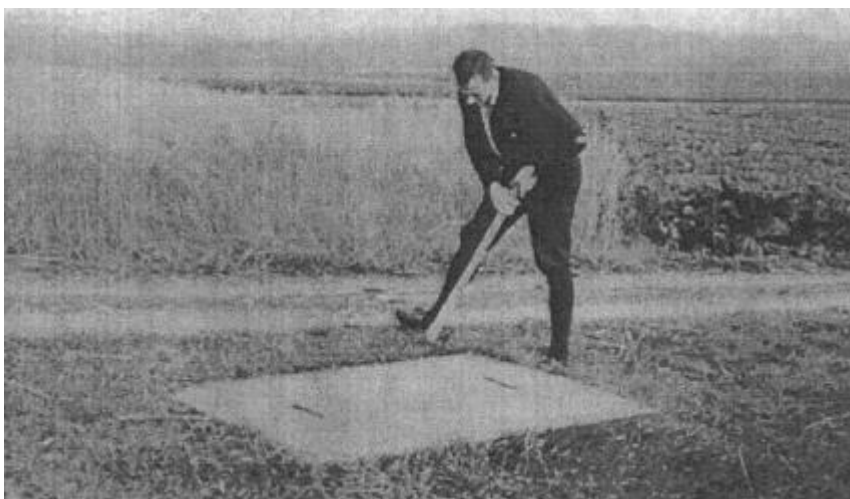
Abb. 39. Einstieg zum Qanat in Wildenau – der Zugang ist mit einer schweren Steinplatte abgedeckt (Klaubert 1967).
