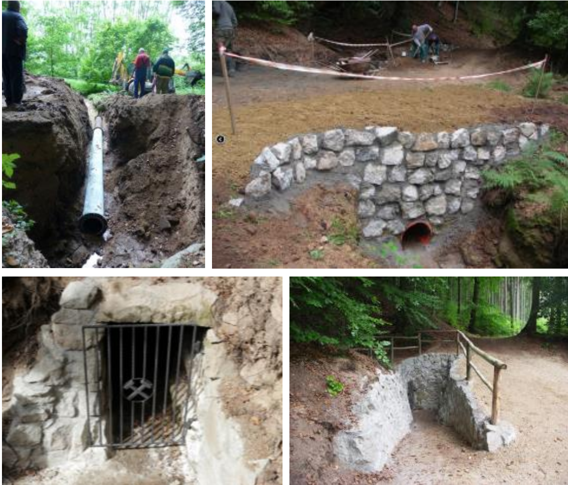
Abb. 45. Wiederherstellung des Mundlochs des Stollens „Weiße Dame“ („Bílá paní“) 2015-2016 ( www.solles.cz ).
