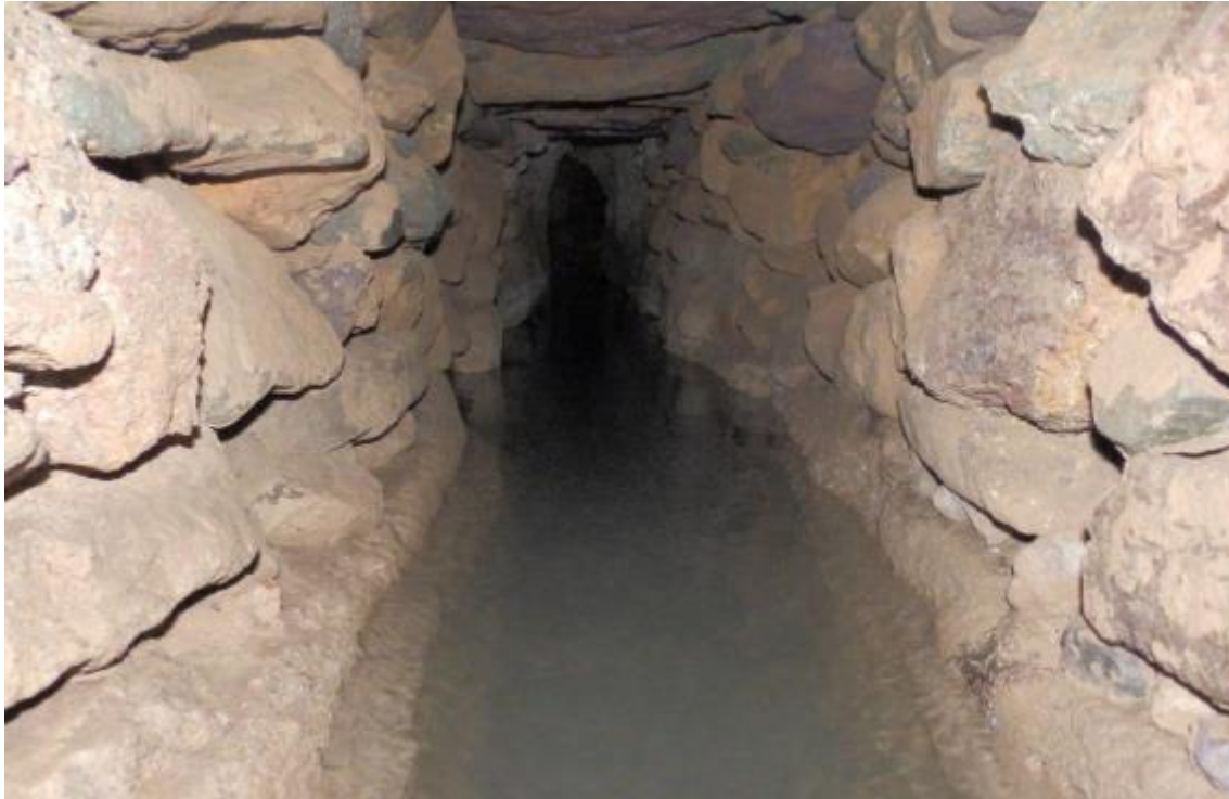
Abb. 14. Steinbefestigung der Zibad-Qanat in Gonabad ( https://en.wikipedia.org/wiki/Gonabad ).
