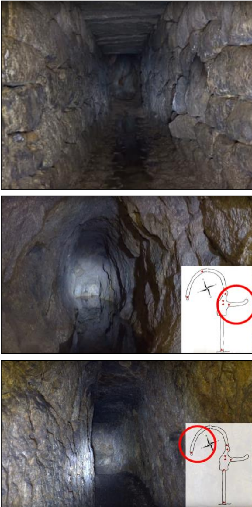
Abb. 47. Der Stollen „Weiße Dame“ („Bílá paní“) bei Tatrovice. Oben: Zugangsbereich mit Steinmauerwerk und einer Decke aus Steinplatten. Mitte: Seitenstrecke mit Grundwasserquelle. Unten: Hauptstrecke (aus dem Video www.solles.cz auf youtube.com ).
