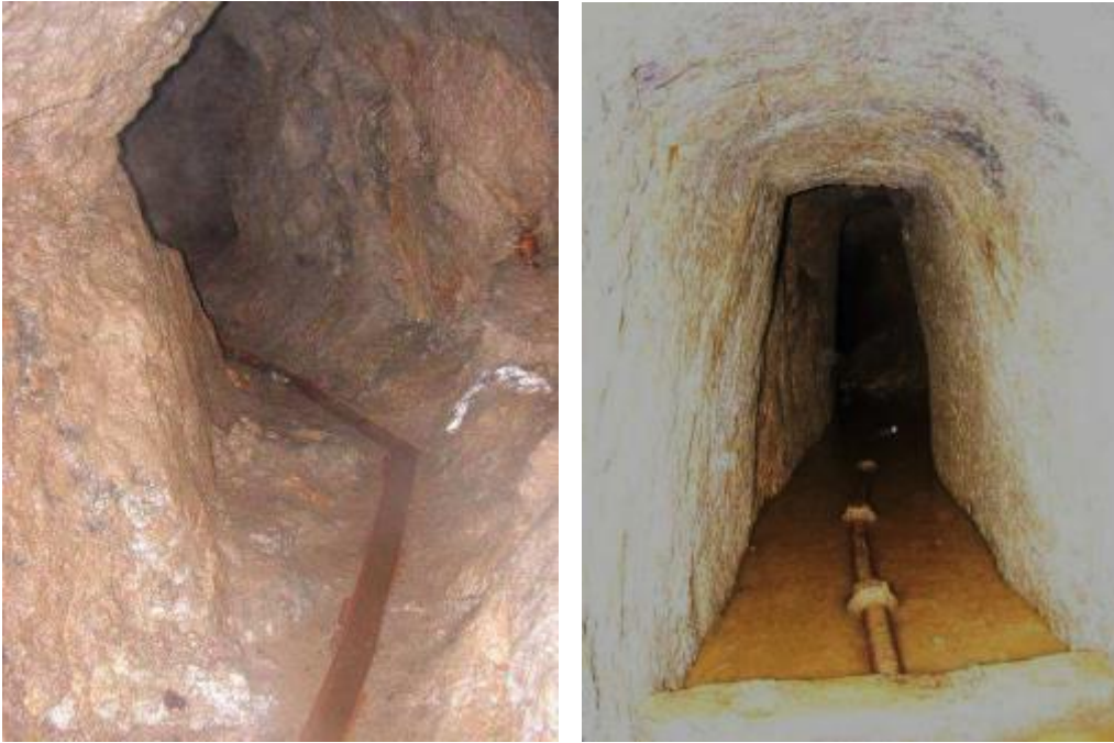
Abb. 43. Links: Entwässerungsrinne im Stollen Aš-Skřivánčí vrch (2012). Rechts: Eisenrohrleitung auf dem Sohle des Aš-Mokřiny-Stollens (2012). Fotos: B. Karban, vollständige Dokumentation im Anhang.
